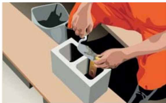
Figura 12: Aplicação das caixas elétricas nos blocos
