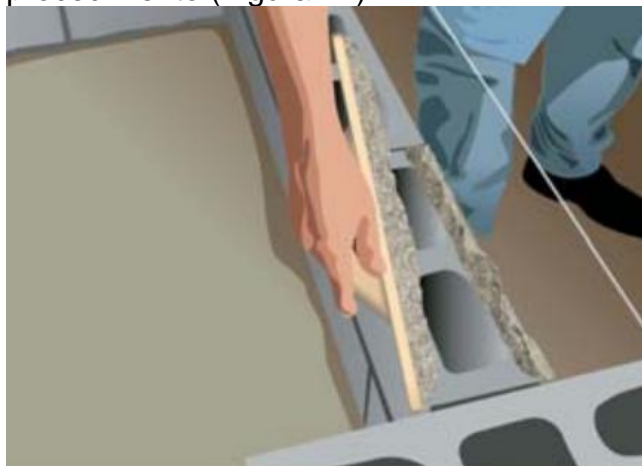
Figura 16: Aplicação da argamassa da parede
