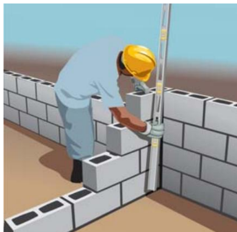
Figura 17: Verificação do prumo e alinhamento
