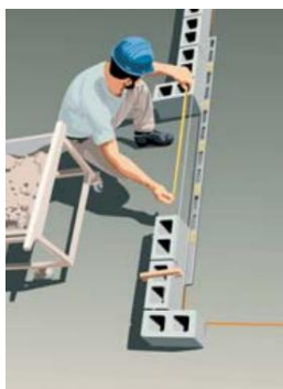
Figura 9: Verificação das aberturas para limpeza
