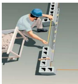
Figura 9: Verificação das aberturas para limpeza
