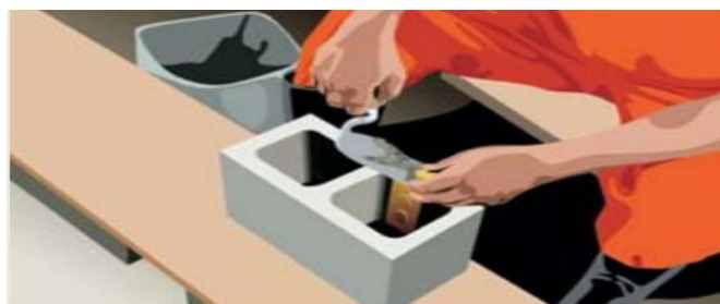
Figura 12: Aplicação das caixas elétricas nos blocos Figura 13: Assentamento do bloco elétrico
