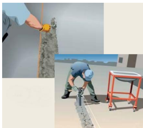
Figura 3: Procedimento para molhar a superfície e Figura 4: Aplicação da argamassa
