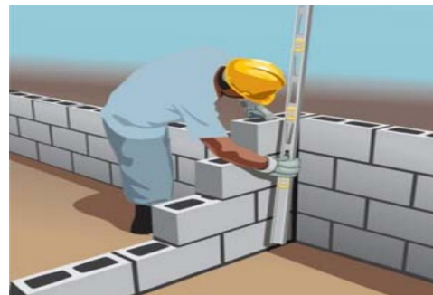
Figura 17: Verificação do prumo e alinhamento
