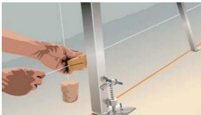
Figura 1: Nivelamento das Fiadas.
