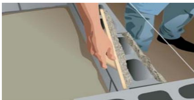
Figura 16: Aplicação da argamassa da parede.
