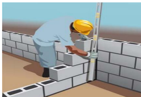
Figura 17: Verificação do prumo e alinhamento da parede.
