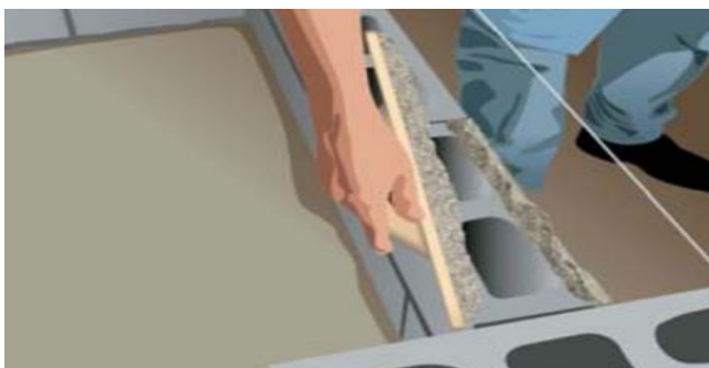
Figura 16: Aplicação da argamassa
