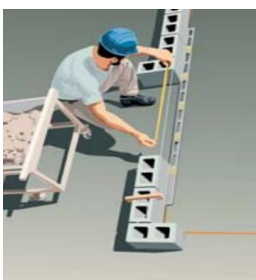
Figura 9: Verificação das aberturas para limpeza
