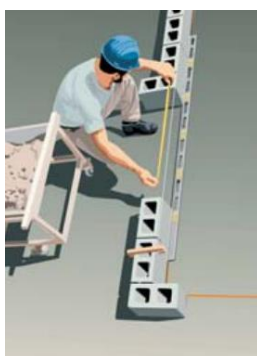
Figura 9: Verificação das aberturas para limpeza
