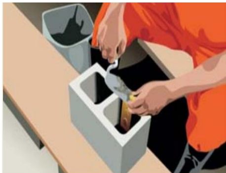
Figura 12: Aplicação das caixas elétricas nos blocos Figura 13: Assentamento do bloco elétrico
