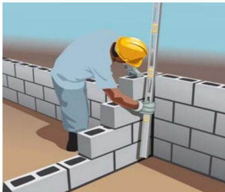
Figura 17: Verificação do prumo e alinhamento da parede.
