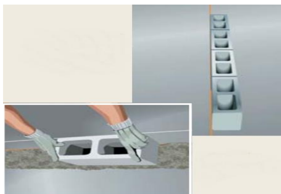
Figura 5: Assentamento do bloco
