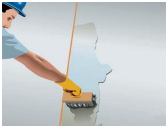
Figura 3: Procedimento para molhar a superfície e Figura 4: Aplicação da argamassa
