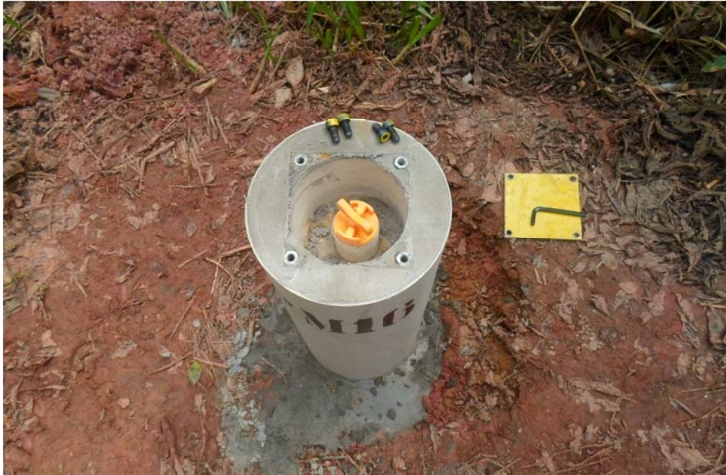
Foto 05. Poço de Monitoramento PM-16 Instalado.
