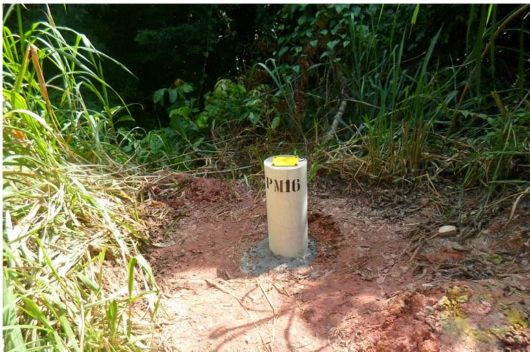
Foto 06. Poço de Monitoramento PM-16 Instalado.
