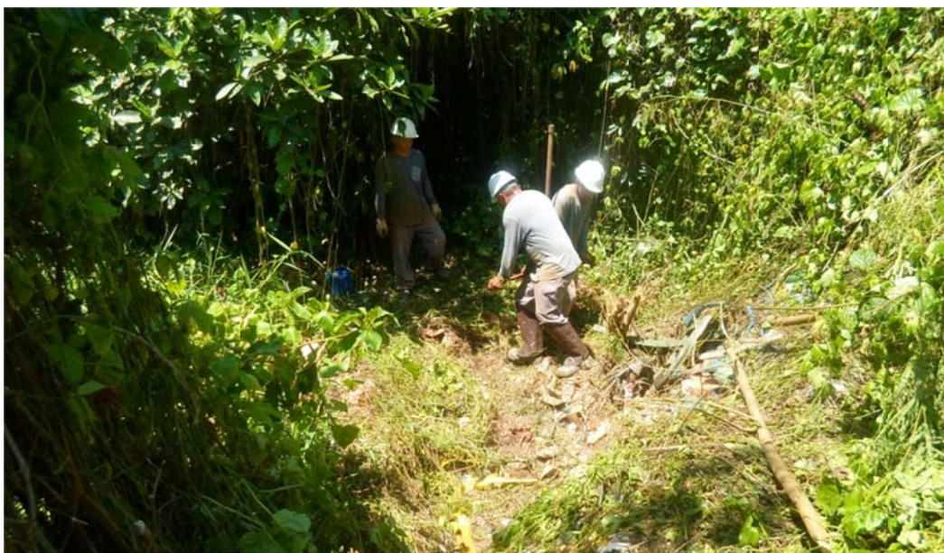
Foto 03. Sondagem Sendo Executada.
