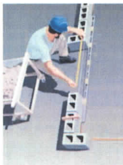
Figura 9: Verificação das aberturas para limpeza
