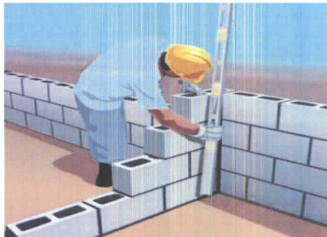
Fig.17: Verificação do prumo e alinhamento da
