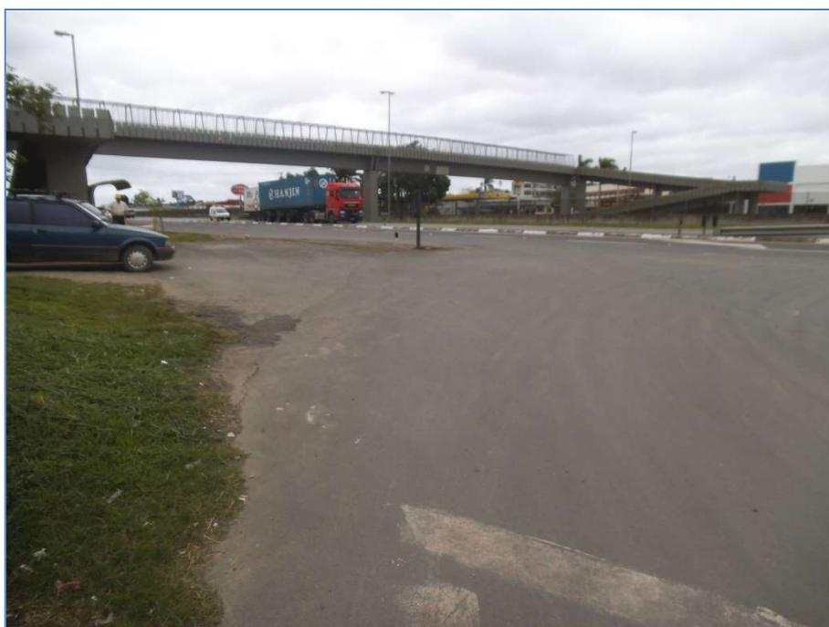
**Foto 1** – Vista para montante da Rua Recife, com a Rodovia Régis Bittencourt ao fundo. Este é o local do desemboque da galeria de águas pluviais projetada para o reforço da travessia existente na rodovia.
