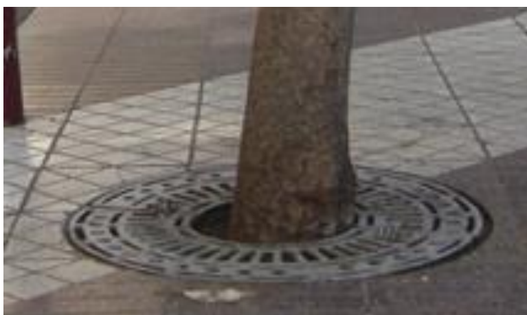
Figura 7: Grelha no centro de ferro fundido.
