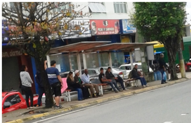
Figura 17.26: Avenida Marginal Sentido São Paulo (abrigo metálico).
