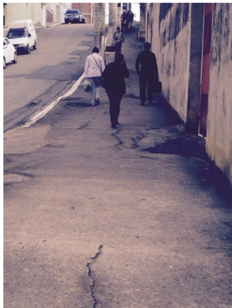
Figura 15.14: Calçada: Rua Meraldo Previde.
