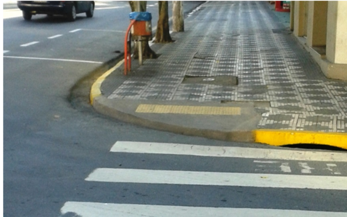
Figura 17.7 - Rebaixamento da calçada na esquina da Rua Cap. João Pocci - Centro.
