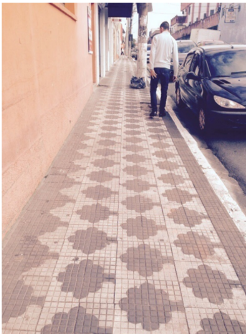
Figura 15.4: Calçada: Rua Getúlio Vargas.
