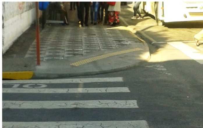
Figura 17.8 - Rebaixamento da calçada na esquina da Rua Cap. João Pocci - Centro.
