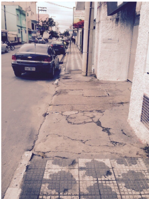
Figura 15.5: Calçada: Rua Shitiro Maeji.
