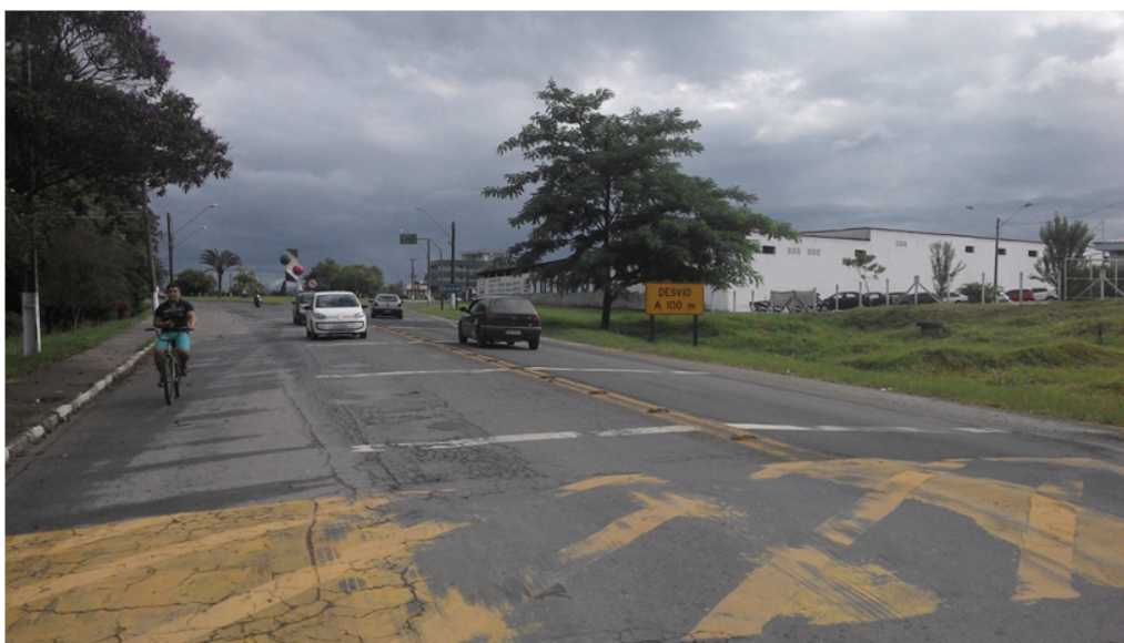
Figura 8.7: Rodovia Empei Hiraide – SP 139: (Sentido Sete Barras-SP).
