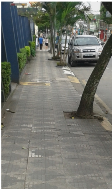
Figura 15.1: Calçada: Rua José Antônio de Campos
