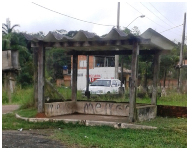
Figura 17.27: Rodovia Régis Bittencourt – sentido SP (abrigo de madeira).
