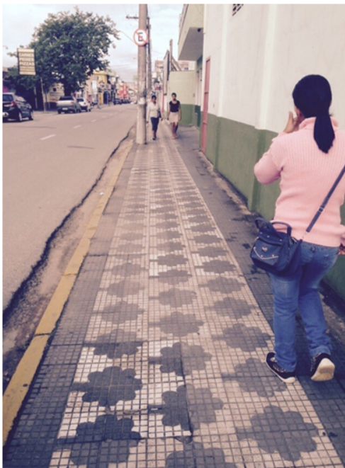
Figura 15.3: Calçada: Rua Tamekichi Takano.
