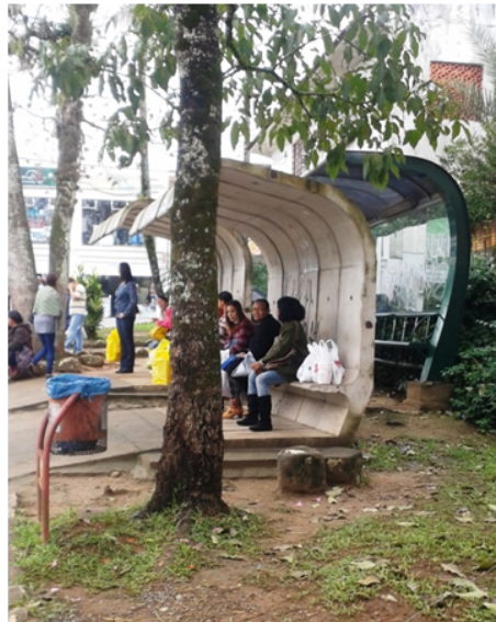
Figura 17.15: Rua Gersoni Napoli – Centro (abrigo de concreto).
