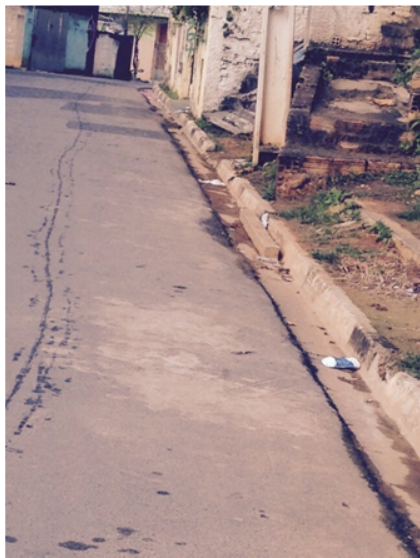
Figura 15.16: Calçada: Vila Nova.
