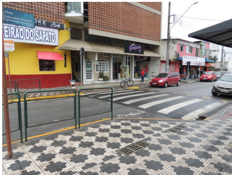
Figura 7.12: Travessia elevada Rua Meraldo Previde - Registro-SP.
