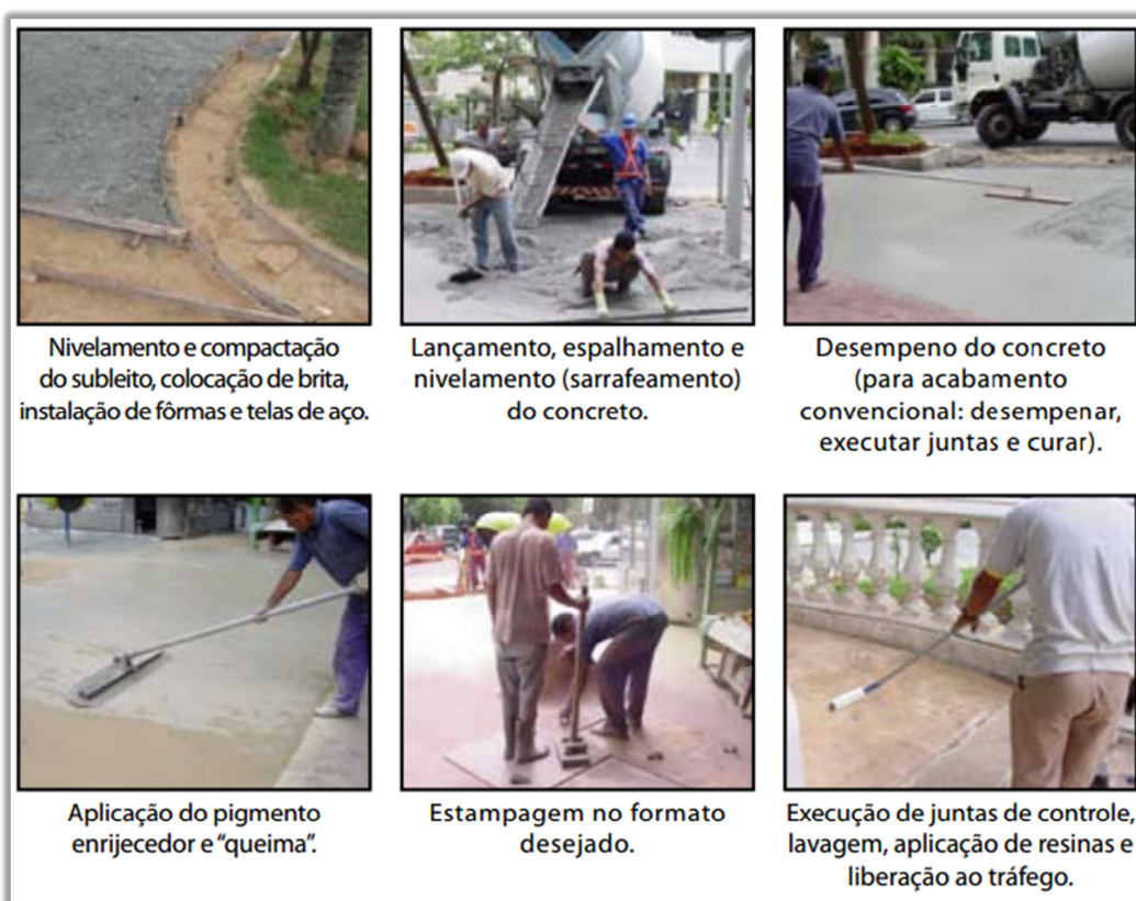
Figura 7.29: Execução passo a passo concreto moldado in loco – concreto estampado.
