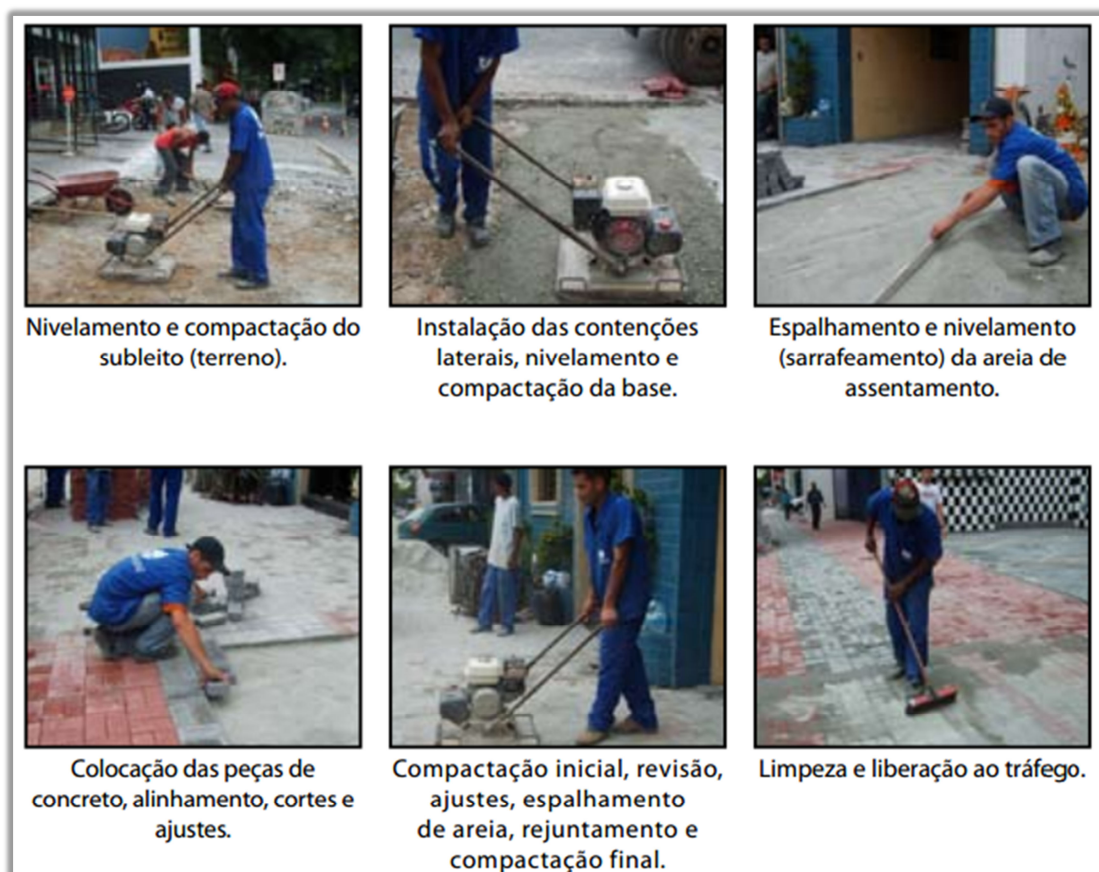
Figura 7.30: Execução passo a passo pavimento intertravado.
