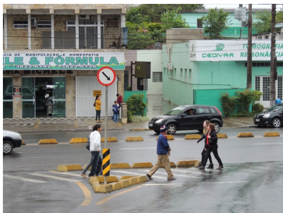
Figuras 7.60, 7.61 e 7.62: Ilha de canalização e refúgio para pedestres.
