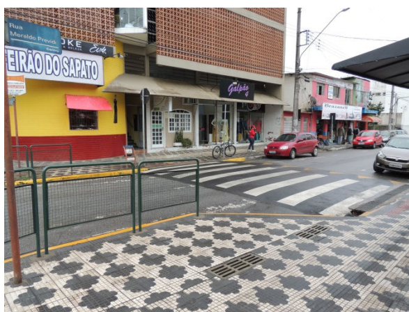
Figura 7.73: Instalação de gradil de proteção.
