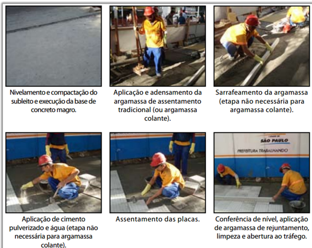
Figura 7.28: Execução passo a passo Ladrilho Hidráulico.
